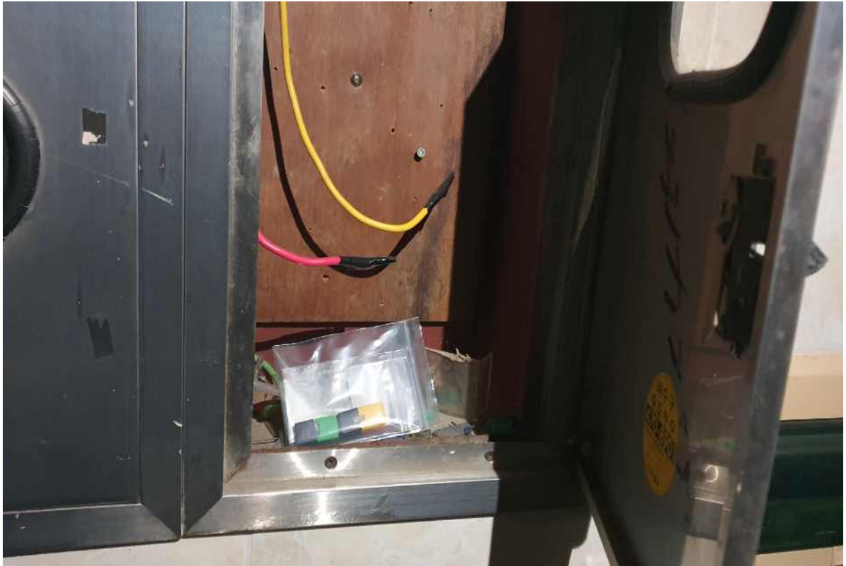
【주택가 전기단자함에 은닉되어 있던 액상대마 카트리지】
